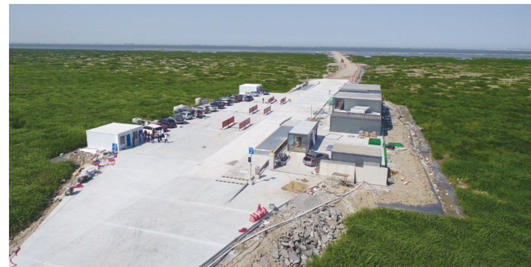
南汇N1渣土消纳入口实景
