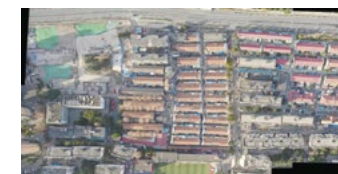
18.杨浦区154街坊项目
