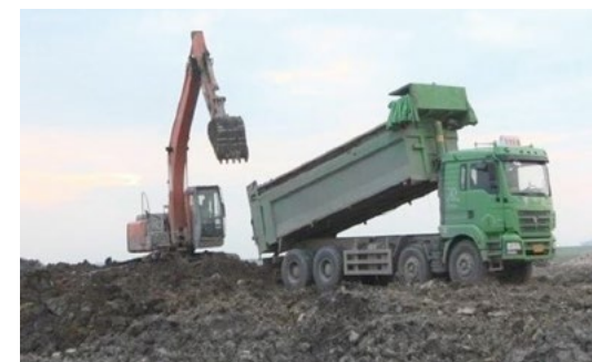
渣土消纳实景
