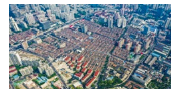
13.虹口区东余杭路一期及二期项目
