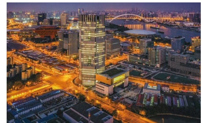
新开发银行总部大楼实景
